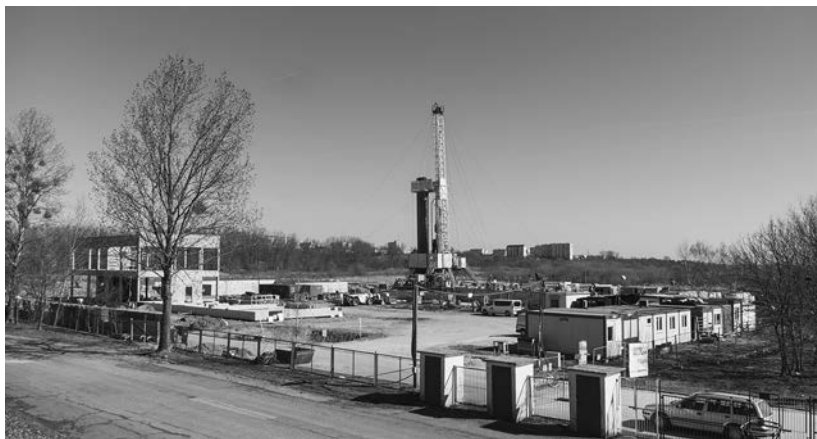
Budowa ciepłowni geotermalnej w Koninie. Fot. B. Kielbasa
